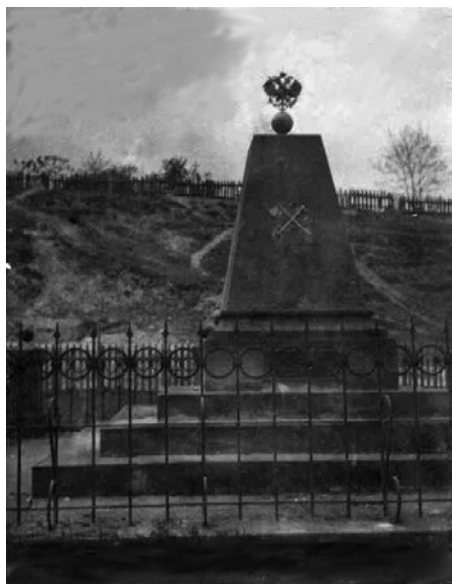
Zawichost. Reper w Zawichoście, 1910 r. Archiwum Instytutu Meteorologii i Gospodarki Wodnej Oddział w Krakowie, Dokumentacja posterunku wodowskazowego Zawichost, s. nlb.
